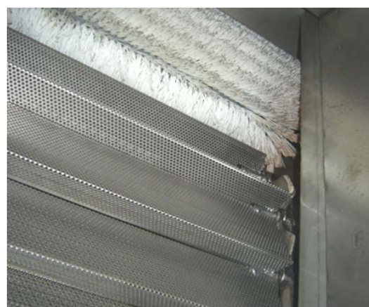
Particolare Pulizia Nastro
